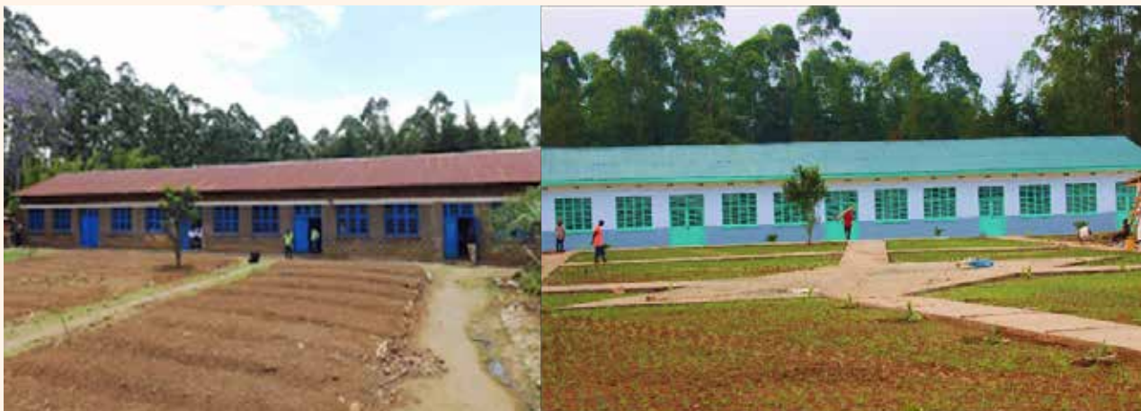
Image 7 : Salles des classes avant et après la réhabilitation
