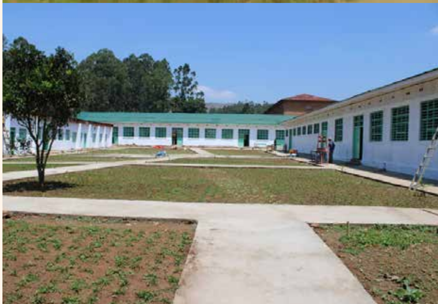
Image 1 : La section technique agricole et les laboratoires de bio-chimie et physique avant et après la réhabilitation
