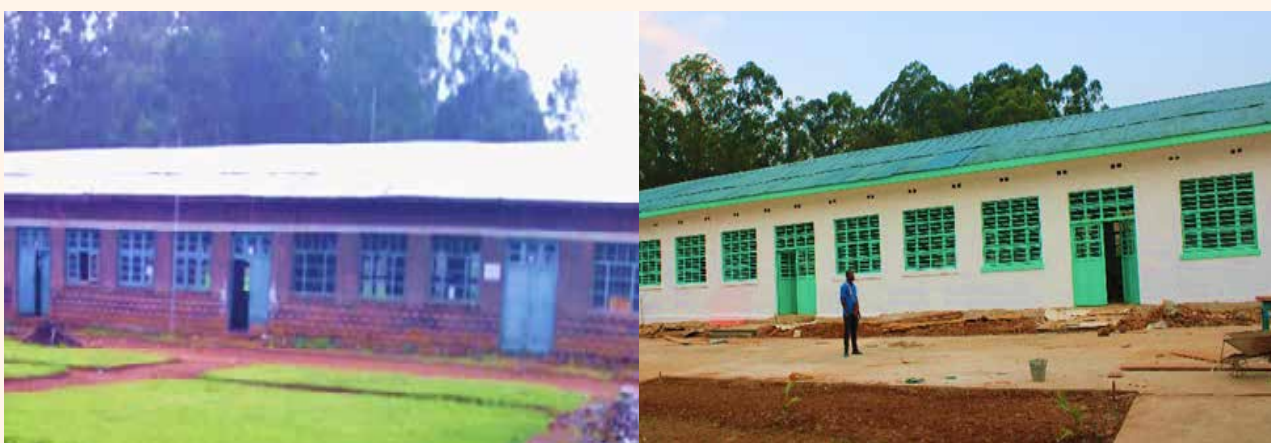
Image 9 : Salles des laboratoires avant et après la réhabilitation
