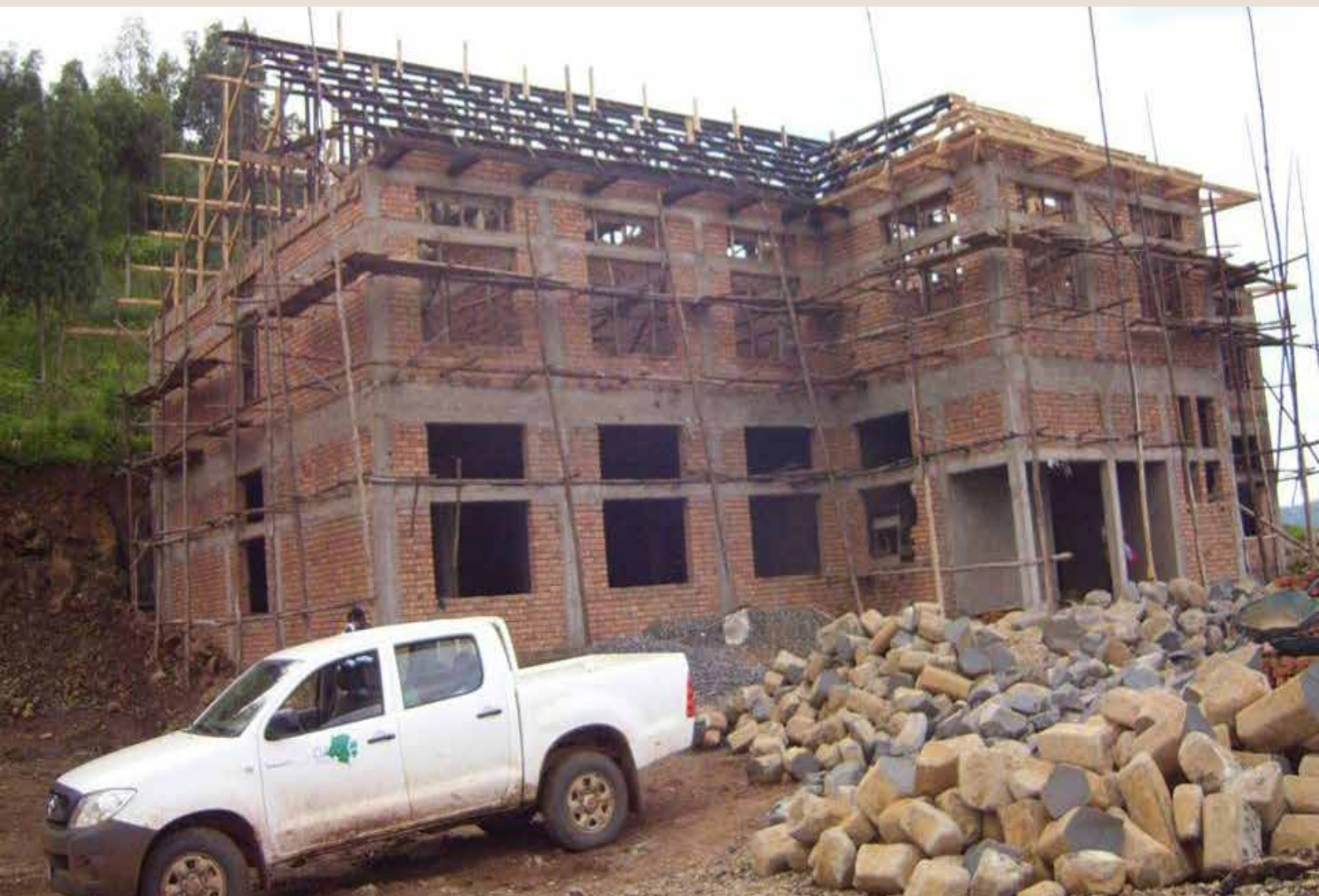
Construction du premier bâtiment en 2009.
