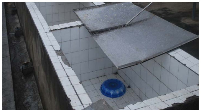
Figure 5b: Fosse de fermentation construite avec des tuiles
