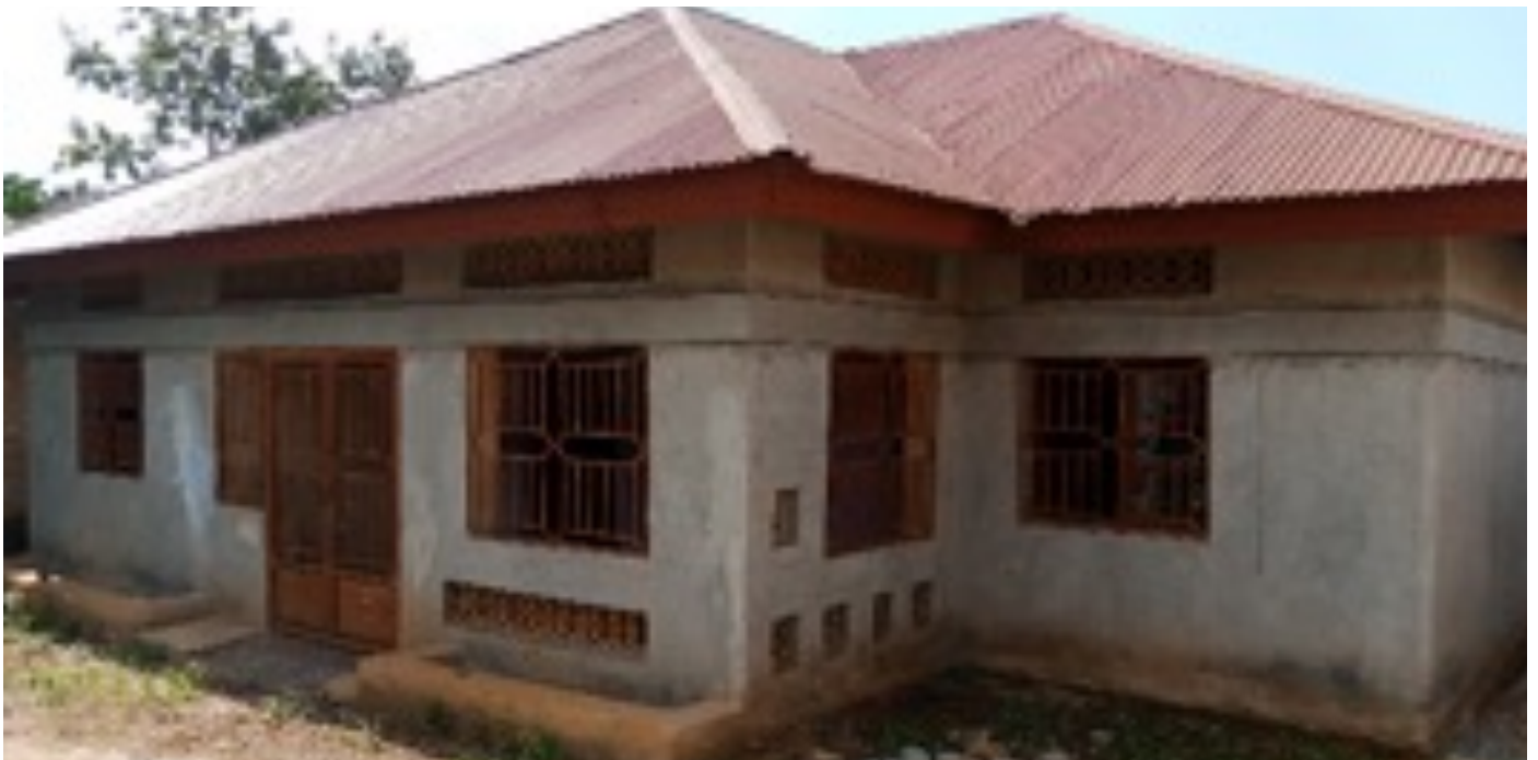
Figure : Bâtiment identifié pour le sous-bureau à Isiro
